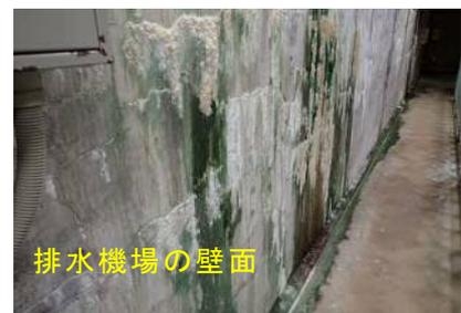
写真-1 壁面のひび割れ状況
